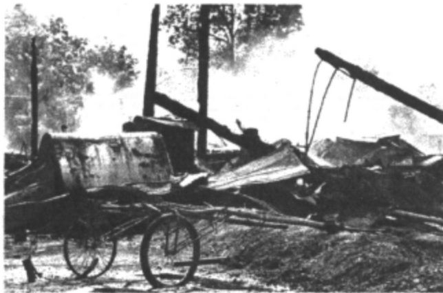
La ferme Bouvrette de St-Jérôme n'est plus que ruine. Les pertes sont évaluées à $200,000, 17 chevaux de race ont péri dans les flammes.
